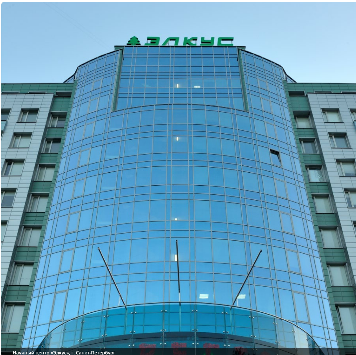
Научный центр «Элкрус», г. Санкт-Петербург
